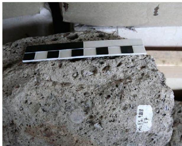
Abb. 3: Werkzeugspuren auf einem Tuffbaustein aus Hollingstedt (Foto: M. Pohl).
