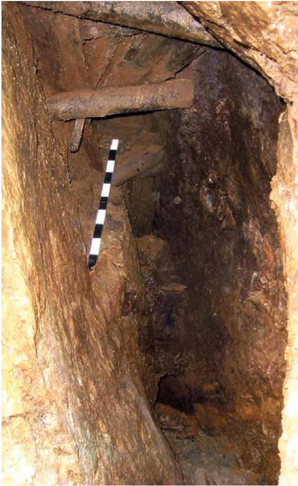
Abb. 2: Dippoldiswalde, Kästen zur Firstsicherung eines als Stollen genutzten Abbaus (Foto: Landesamt für Archäologie Sachsen).
