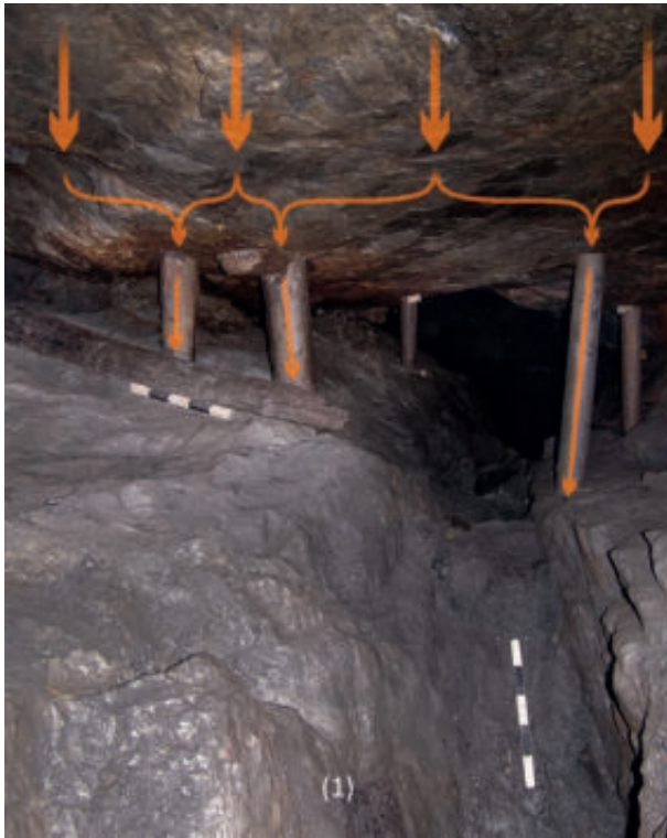
Abb. 109: Verzimmerungen in unterschiedlich gestalteten Hohlräumen des prähistorischen Bergbaus im Arthurstollen mit schematisch eingetragenen Bergdruck (gelbe Pfeile). 1 – Fundstelle 4650 mit der mittleren Bühne und rezenten Verzimmerungen in der rechten Bildhälfte (Blickrichtung: Südosten; Länge der Maßstäbe: jeweils 50 cm; Foto: DBM); 2 – Der obere Bereich von Fundstelle 4635 mit Bühne (Blickrichtung: Westen; Foto: DBM).
