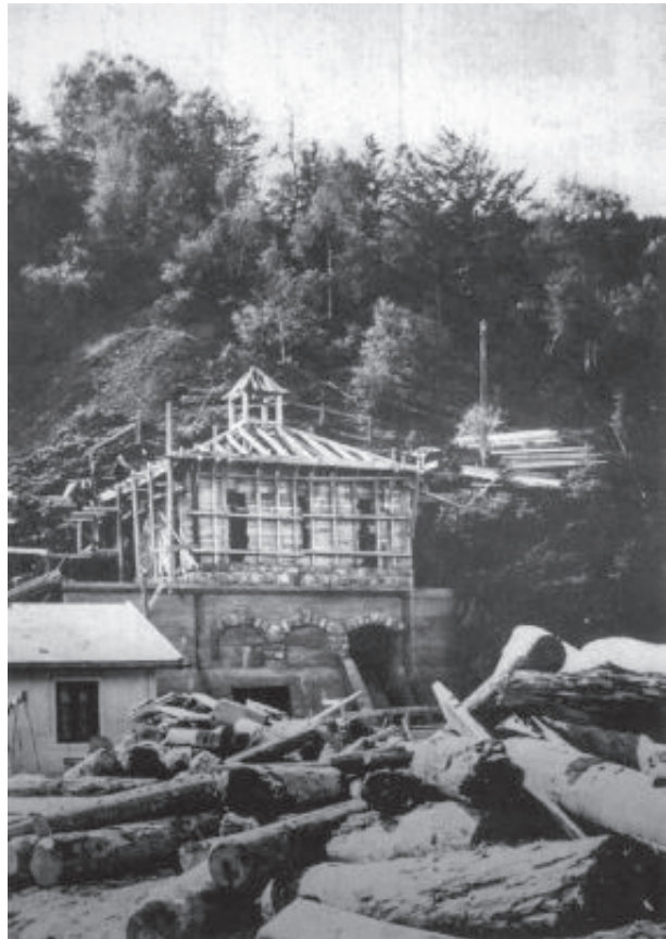
Abb. 19: Bau des Wasserschlosses im Jahr 1928 (nach: Günther, 1993).
