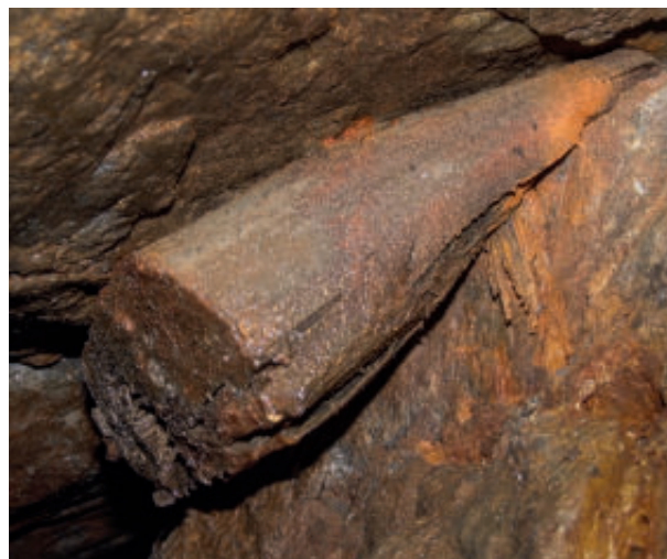
Abb. 107: Ein dicker Schwartling, der am Ansatz der Oststrecke an Fundstelle 4650 als Keil in eine Kluft im Gestein geschlagen wurde (nicht detailliert aufgenommen; Blickrichtung: Nordwesten; Foto: DBM).
