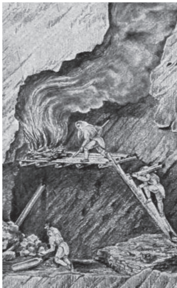
Abb. 241: Die Feuerbühne aus dem Verhau von 1867 nach einer Zeichnung Johann Pirchls (Detail; siehe: Abb. 201).
