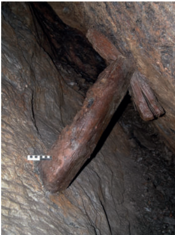
Abb. 98: Der Einzelstempel Nr. 1568 mit dem Spältling Nr. 1569 als Kopfholz an Fundstelle 4650 (Blickrichtung: Nordosten; Länge des Maßstabs: 10 cm; Foto: DBM).
