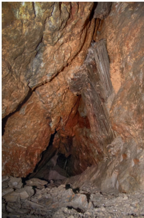
Abb. 33: Im Versatz ausgesparte Strecke im westlichen Gangteil an Fundstelle 4650. Zu beachten ist der massive Stempel am rechten Stoß, dessen oberes Ende durch den Bergdruck bereits stark deformiert ist (Blickrichtung: Nordwesten; Foto: DBM).
