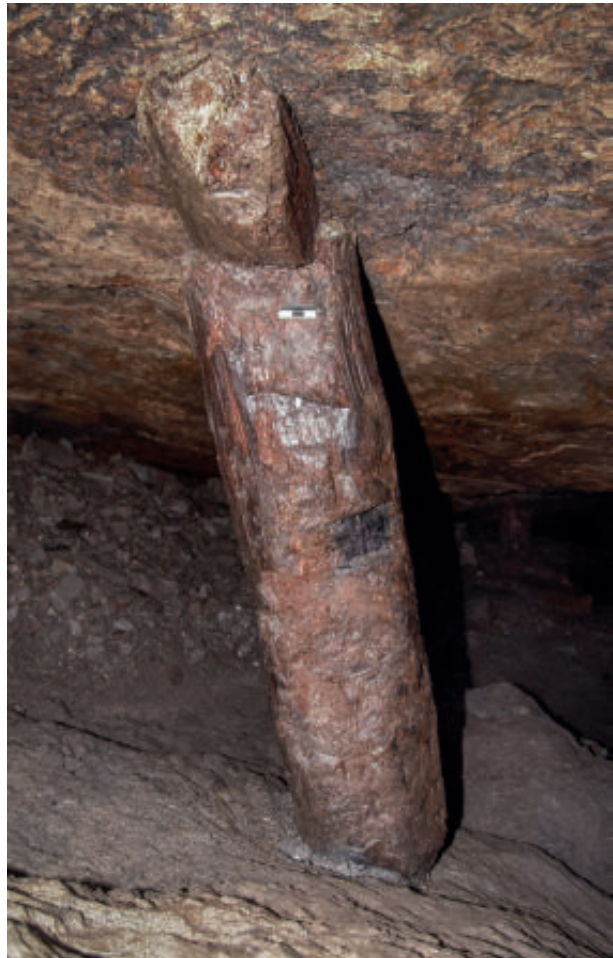
Abb. 111: Stempelzimmerung mit dem Stempel Nr. 1568 und dem radialen Spältling Nr. 1569 als Kopfholz an Fundstelle 4650 (Blickrichtung: Südosten; Länge des Maßstabs: 3 cm; Foto: DBM).
