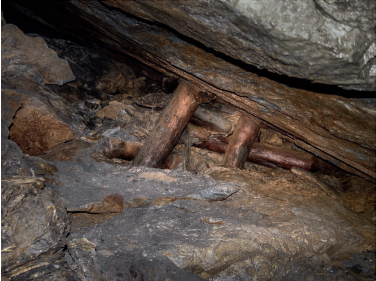
Abb. 95: Die mittlere Bühne an Fundstelle 4650 vor dem Beginn der Grabungsarbeiten (Ansicht von unten). Der Zwischenraum zwischen den Stempeln ist durch zahlreiche Hölzer abgedichtet. Darauf lagern Versatz sowie große Verbruchplatten (Blickrichtung: Norden; Foto: DBM).
