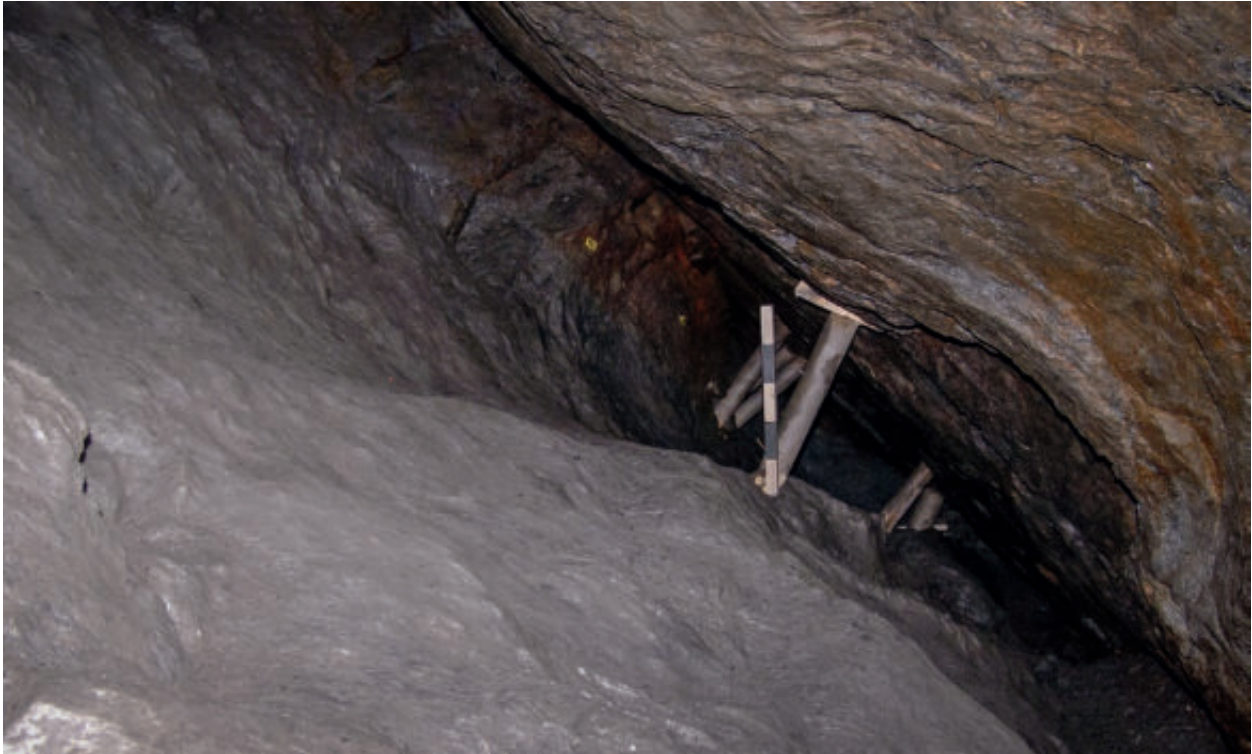
Abb. 35: Der Ansatz der Oststrecke an Fundstelle 4650. Deutlich zu erkennen sind die Reste des ehemaligen Streckenprofils, das vor allem im Liegenden der Verwerfung angelegt wurde. Das Hangende blieb weitgehend unverritzt (die Verzimmerungen sind rezent; Blickrichtung: Osten; Länge des Maßstabs: 50 cm; Foto: DBM).
