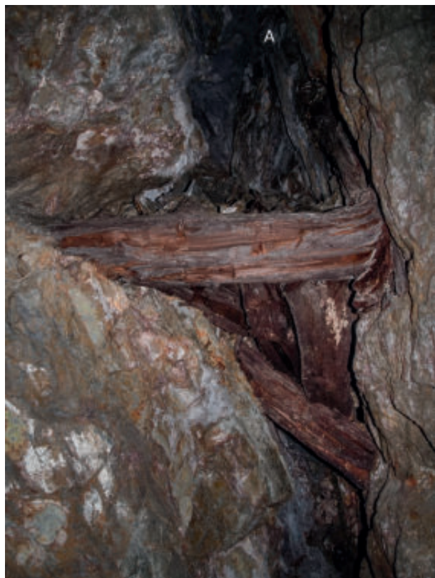
Abb. 113: Die Bühne an Fundstelle 4635 mit teilweise verbrochenem Felspfeiler (A), zu dessen Sicherung die Bühne möglicherweise eingezogen wurde (Blickrichtung: Westen; Foto: DBM).
