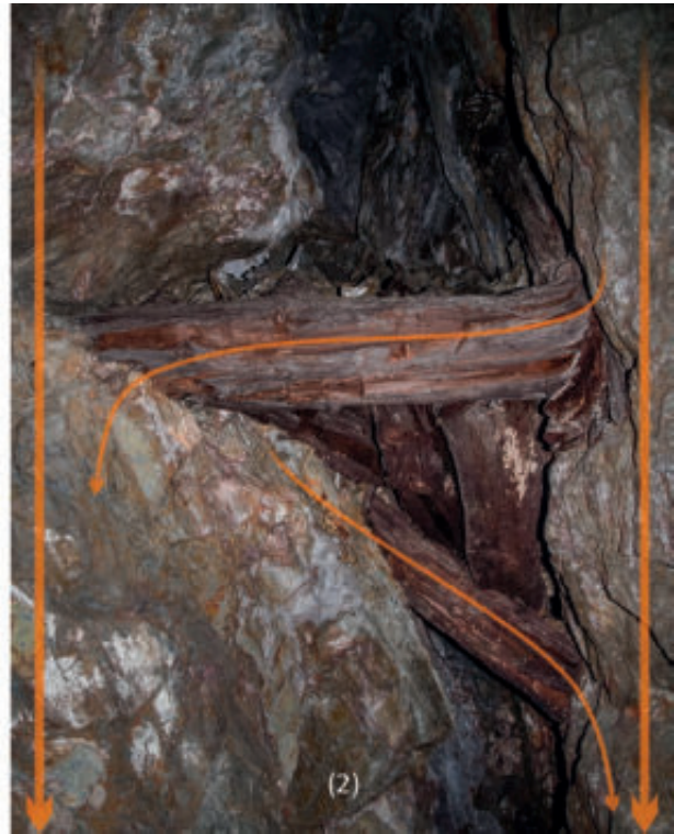
Abb. 109: Verzimmerungen in unterschiedlich gestalteten Hohlräumen des prähistorischen Bergbaus im Arthurstollen mit schematisch eingetragenen Bergdruck (gelbe Pfeile). 1 – Fundstelle 4650 mit der mittleren Bühne und rezenten Verzimmerungen in der rechten Bildhälfte (Blickrichtung: Südosten; Länge der Maßstäbe: jeweils 50 cm; Foto: DBM); 2 – Der obere Bereich von Fundstelle 4635 mit Bühne (Blickrichtung: Westen; Foto: DBM).
