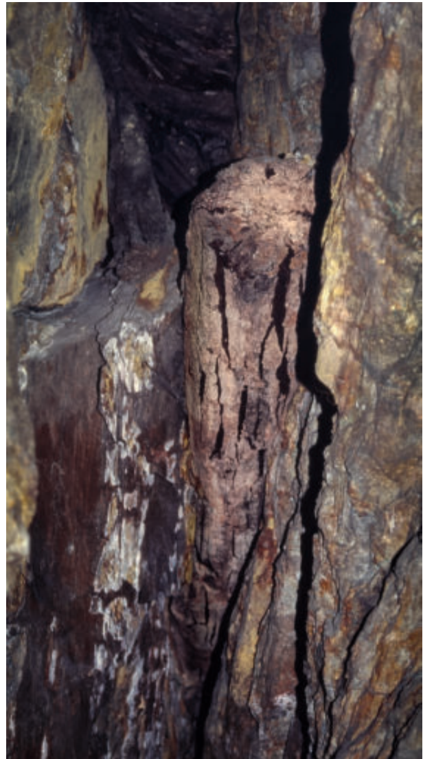
Abb. 105: Stammrundholz, horizontal zwischen die Stöße eingeklemmt (nicht detailliert aufgenommen; westlicher Erzgangteil an Fundstelle 4650; Blickrichtung: Nordwesten; Foto: DBM).
