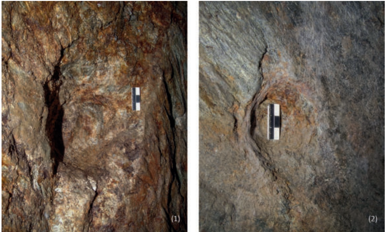
Abb. 83: Artificielle Bühnenlöcher unterschiedlicher Größe an den Stößen im Abbau: 1 – Fundstelle 4700; 2 – Fundstelle 4635 (Länge des Maßstabs: jeweils 3 cm; Fotos: DBM).
