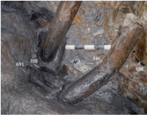
Abb. 87: Zweigliedrige Stempelzimmerung aus den Hölzern Nr. 746 und Nr. 698 an Fundstelle 4635. Links neben dem unteren Stempelende der mögliche Stempelschuh Nr. 691 (Blickrichtung: Osten; Länge des Maßstabs: 50 cm; Foto: DBM).
