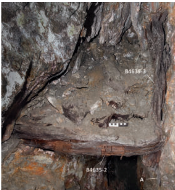
Abb. 90: Der östliche Stempel B4635-2 der Bühne an Fundstelle 4635 mit dem Kopfholz B4635-3 (Blickrichtung: Westen; Länge des Maßstabs: 10 cm; Foto: DBM).
