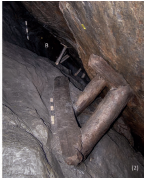
Abb. 119: Fundstelle 4650. Die mittlere Bühne stellt die Verbindung zwischen einer Laufschrift im ausgeerzten Gang (A) und dem Beginn der Oststrecke (B) dar. Gleichzeitig bildet sie eine der wenigen ebenen Flächen an dieser Fundstelle, an der die Bearbeitung von Hölzern möglich war (1 – die Einzelstempel sind rezent; Blickrichtung: Südosten; Länge der Maßstäbe: jeweils 50 cm; Foto: DBM; 2 – die Verzimmerungen in der Oststrecke sind rezent; Blickrichtung: Nordosten; Länge der Maßstäbe: jeweils 50 cm; Foto: DBM).
