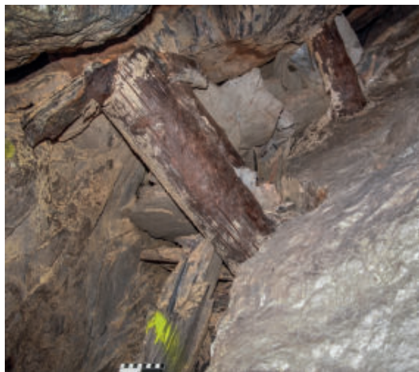
Abb. 101: Die beiden Einzelstempel Nr. 1565 (unten) und Nr. 1567 (oben) an Fundstelle 4650 (Blickrichtung: Nordwesten; Länge des Maßstabs: 10 cm; Foto: DBM).
