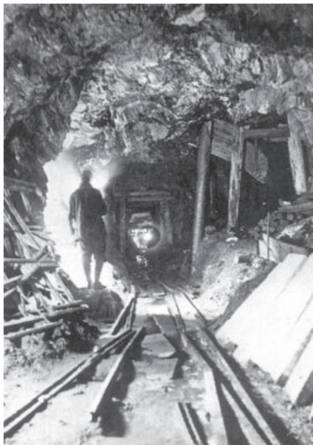
Abb. 20: Gewaltigungsarbeiten im Arthurstollen im Jahr 1955 (nach: Günther, 1993).
