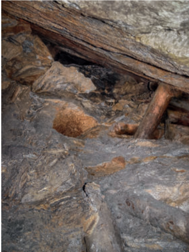
Abb. 108: Fundstelle 4650 vor Beginn der Grabungsarbeiten. Der Hohlraum ist teilweise verfüllt mit großen Versturzböcken und verbrochenen Verzimmerungen (im Vordergrund zwei Stempel). Am rechten Bildrand ist die mittlere Bühne zu sehen (Blickrichtung: Norden; Foto: DBM).
