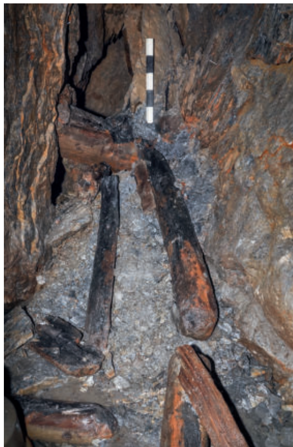
Abb. 34: Unversetzter Grubenhohlraum im westlichen Gangteil an Fundstelle 4650 mit Resten einer ehemals massiven Verzimierung (Blickrichtung: Nordwesten; Länge des Maßstabs: 50 cm; Foto: DBM).
