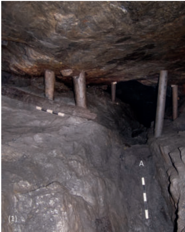
Abb. 119: Fundstelle 4650. Die mittlere Bühne stellt die Verbindung zwischen einer Laufschrift im ausgeerzten Gang (A) und dem Beginn der Oststrecke (B) dar. Gleichzeitig bildet sie eine der wenigen ebenen Flächen an dieser Fundstelle, an der die Bearbeitung von Hölzern möglich war (1 – die Einzelstempel sind rezent; Blickrichtung: Südosten; Länge der Maßstäbe: jeweils 50 cm; Foto: DBM; 2 – die Verzimmerungen in der Oststrecke sind rezent; Blickrichtung: Nordosten; Länge der Maßstäbe: jeweils 50 cm; Foto: DBM).
