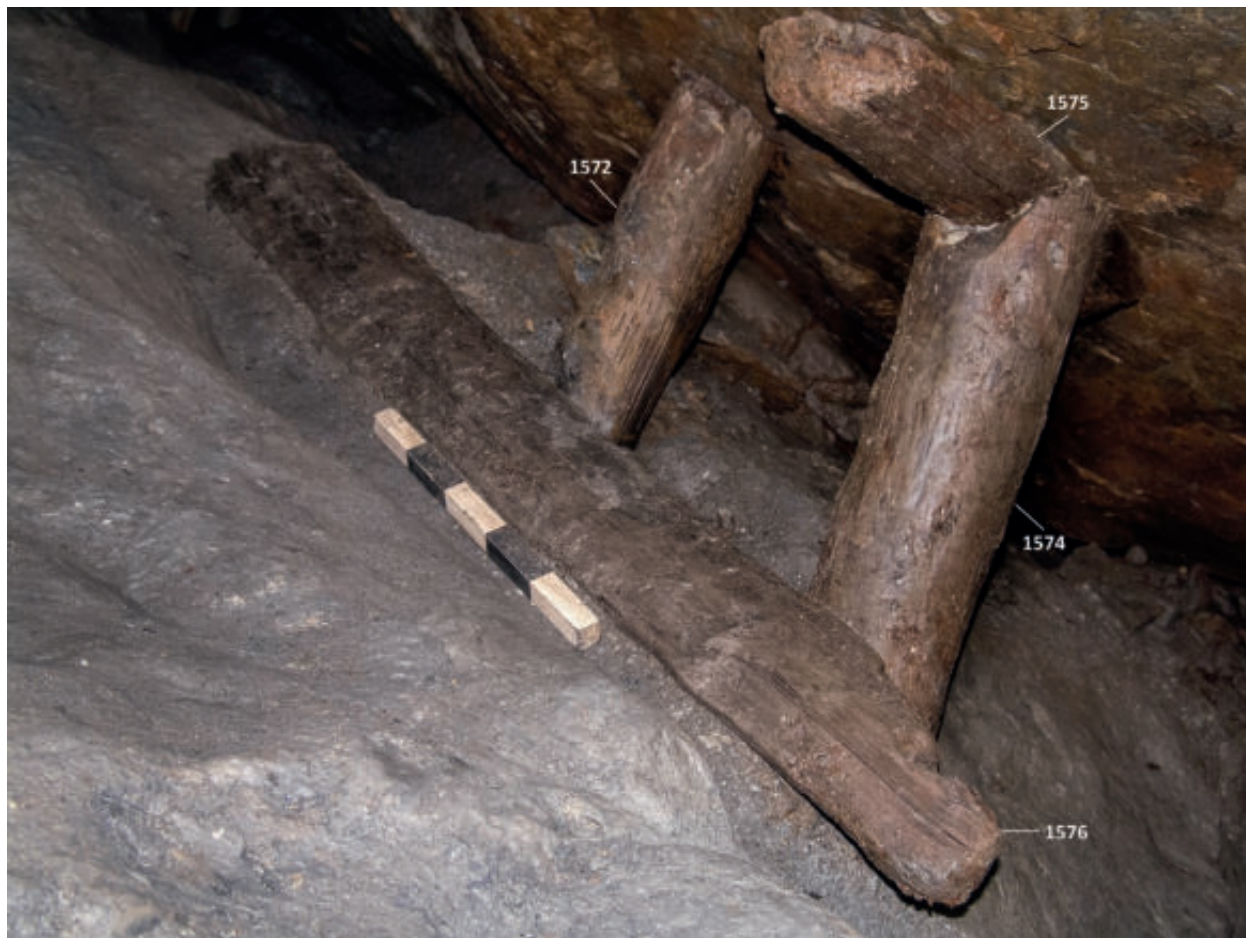
Abb. 96: Die mittlere Bühne an Fundstelle 4650 nach der Freilegung mit der primären Auflage des Schwartlings Nr. 1576. Der rechte Stempel gehört zum Typ RH-S-1 und ist mit einem Schwartling als Kopfholz eingesetzt. Dieses ruht in einer runden Kehle, die zusammen mit einer einseitigen Fasse das obere Stempelende bildet (Blickrichtung: Osten; Länge des Maßstabs: 50 cm; Foto: DBM).
