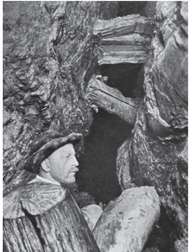
Abb. 8: Die alten Verhaue im Arthurstollen mit in situ-Verzimmern (nach: Kyrle, 1918b).
