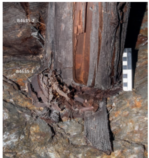
Abb. 91: Das untere Ende des Kopfholzes B4635-3 mit dem untergeschobenen dünnen Brett (A) als zusätzliches Futter (Blickrichtung: nach oben; Länge des Maßstabs: 10 cm; Foto: DBM).
