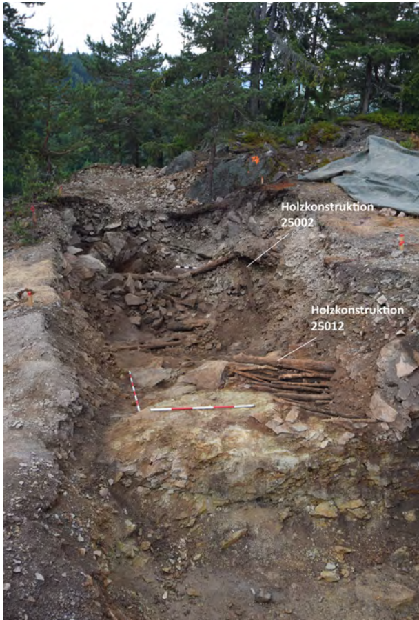
Abb. 103: Schnitt 1 und 2, Blick nach West. Möglicherweise gehören die Holzkonstruktionen 25002 und 25012 zu demselben Stollen, der von West nach Ost verlief (Foto: Deutsches Bergbaumuseum Bochum/J. Garner).
