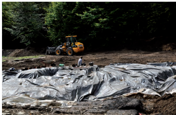
Abb. 169: Gerhardsseifen: Abdecken der stabilisierten Befunde mit Plane (Foto: LWL-Archäologie für Westfalen/M. Zeiler).
