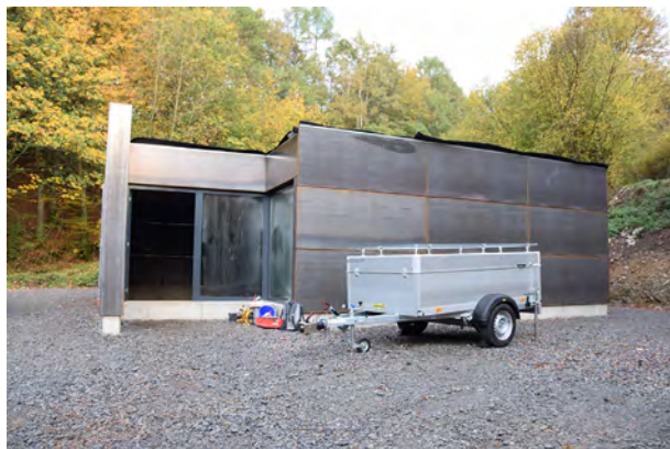
Abb. 187: Der Schutzbau im Oktober (Foto: Restaurierung am Oberbaum).
