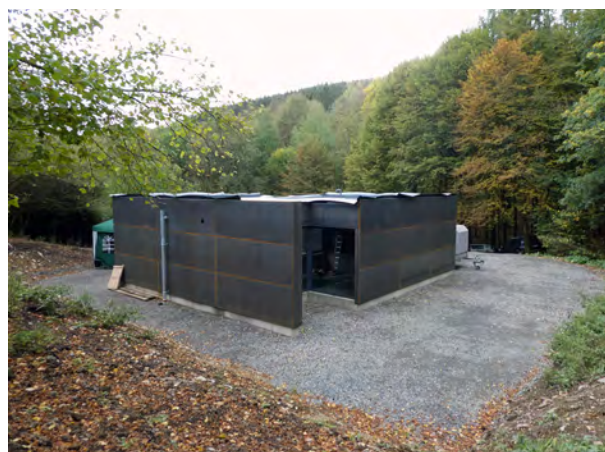
Abb. 175: Blick von NW auf den eingekleideten sowie teilabgedeckten Schutzbau am 10. Oktober 2019 (Foto: LWL-Archäologie für Westfalen/M. Zeiler).
