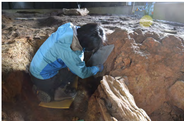
Abb. 197: S. Toyoda beim Einpassen einer Stützkonstruktion in einem absturzgefährdeten Bereich (links); Zwischenzustand (rechts) (Foto: Restaurierung am Oberbaum).
