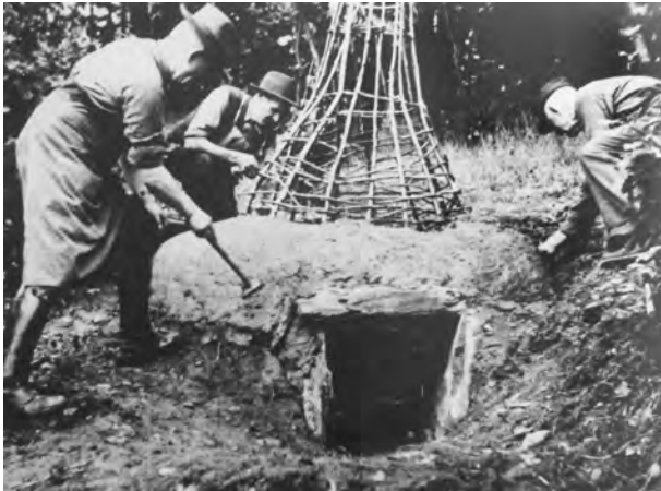
Abb. 142: Bau des Experimentofens 1957 (Foto: H. G. Koch im Bergbaumuseum des Kreises Altenkirchen).
