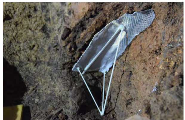
Abb. 197: S. Toyoda beim Einpassen einer Stützkonstruktion in einem absturzgefährdeten Bereich (links); Zwischenzustand (rechts) (Foto: Restaurierung am Oberbaum).
