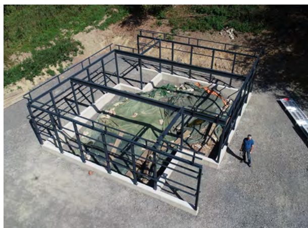
Abb. 174: Blick von SO auf das fertige Stahlgerüst des Schutzbaus am 4. September 2019 (Foto: LWL-Archäologie für Westfalen/M. Zeiler).
