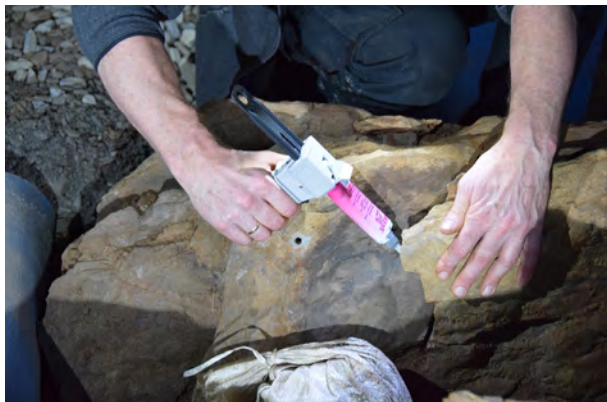
Abb. 196: Auftragen des 2K-Epoxidharzes auf die Klebefläche (links); Endzustand der Klebestelle (rechts) (Foto: Restaurierung am Oberbaum).
