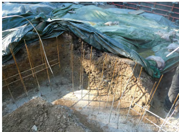
Abb. 172: Anlage der Streifenfundamentgräben. Blick von NW auf die teilangeschnittene mittelalterliche Schlackengrube hinter der Armierung am 17. Juni 2019 (Foto: LWL-Archäologie für Westfalen/M. Zeiler).
