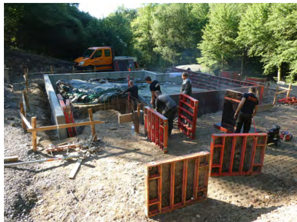
Abb. 173: Blick von NW auf die Anlage der Streifenfundamente mit Einbau der Verschalung in die Fundamentgräben am 17. Juni 2019 (Foto: LWL-Archäologie für Westfalen/M. Zeiler).
