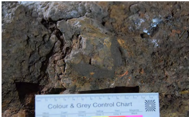
Abb. 193: Hohlraumverfüllung und Randanböschung (links); Randanböschung unter einem Überhang (rechts) (Foto: Restaurierung am Oberbaum).
