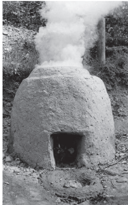
Abb. 26 Rekonstruktion einer der Gebläseöfen von Podium 1 im Jahre 1964. Foto: Fotograf unbekannt.
