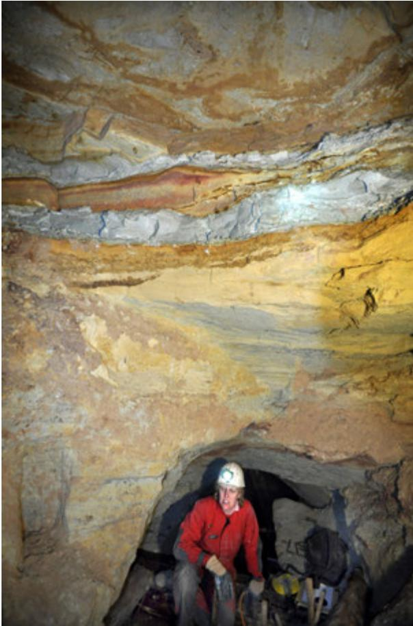
Abb. 139: Blick aus der Verbruchzone Richtung bergauswärts, 2011. Gut erkennbar die Abfolge der Sandstein- und Lettenschichten. Links unten im Bild ein großzügig ausgearbeiteter Absatz im Stoß (Foto: Deutsches Bergbau-Museum Bochum/G. Steffens).
