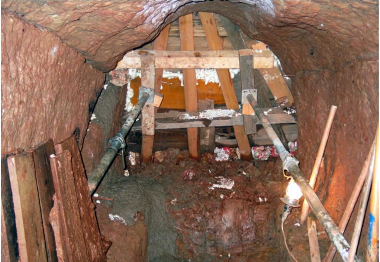
Abb. 270: Der Bereich vor dem Verbruch wurde verschalt und abgedichtet (Foto: Deutsches Bergbau-Museum Bochum/S. Müller).
