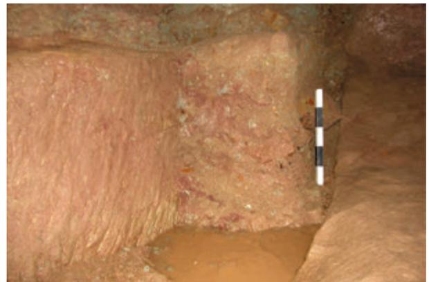
Abb. 109: Im Vordergrund ist die Wasserseige zwischen Lfm. 45 und Lfm. 46 zu sehen, 2009. Direkt hinter ihr befindet sich die Verbruchzone, rechts im Bild die abgesenkte rechte Sohle, in der Mitte die inhomogene Verfüllung aus rötlichem, lehmigem und grauem, tonigem Material sowie Steinen (Foto: Deutsches Bergbau-Museum Bochum/G. Körlin).
