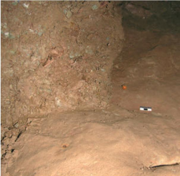
Abb. 251: Eisennagel in der Stollensohle bergewärts hinter dem Kriechgang, links oberhalb des Maßstabs. Unten links im Bild ist der in der Sohle steckende Rest des zweiten, abgebrochenen Nagels zu erkennen (Foto: Deutsches Bergbau-Museum Bochum/G. Körlin).
