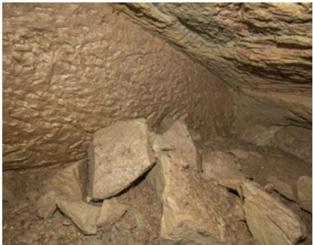
Abb. 150: Blick auf den sauber gearbeiteten Südstoß, 2022. Vorne im Bild größere Steinblöcke, die abgebaut, aber mitten im Raum liegen gelassen wurden (Foto: Deutsches Bergbau-Museum Bochum/G. Steffens).
