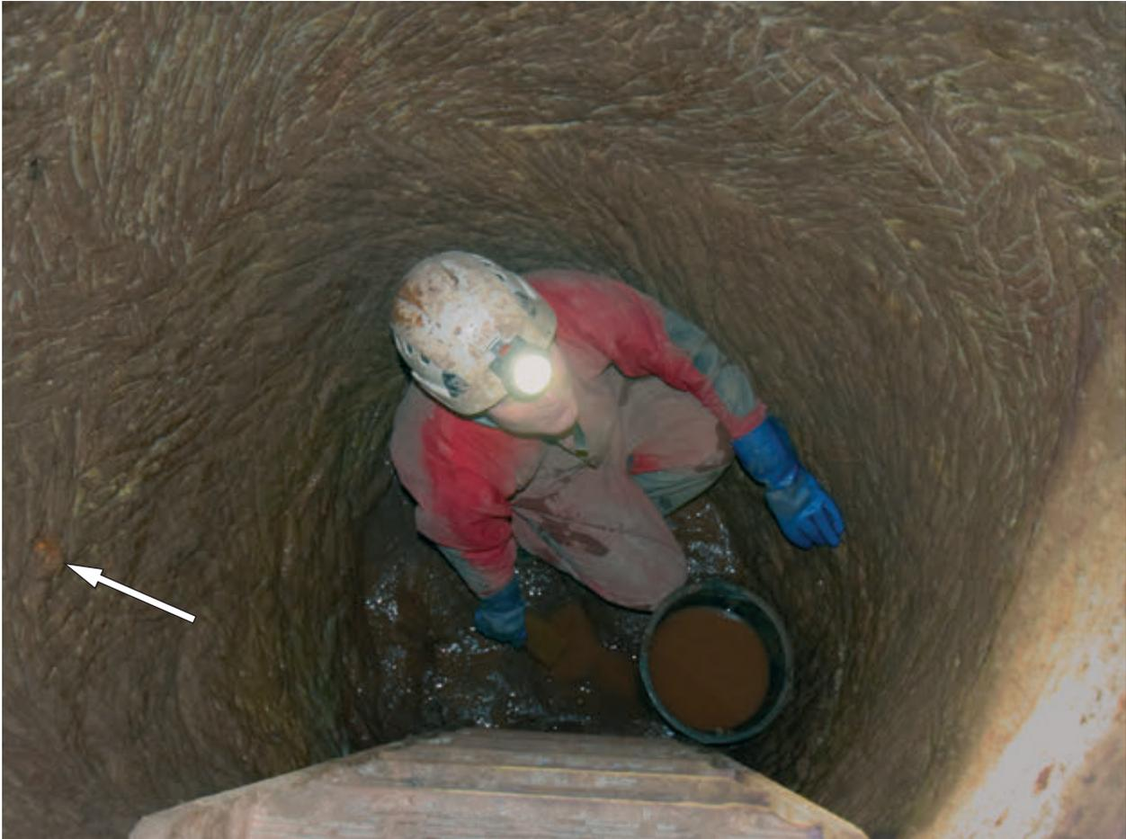
Abb. 224: Blick in das Gesenk mit den umlaufenden Reihen von Pickspuren, 2019. Links im Bild der Eisenbolzen (Foto: Deutsches Bergbau-Museum Bochum/G. Körlin).
