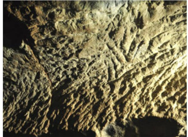
Abb. 124: Bei Streiflicht heben sich die tiefen Keilhauespuren besonders deutlich ab, 2013 (Foto: Deutsches Bergbau-Museum Bochum/G. Körlin).
