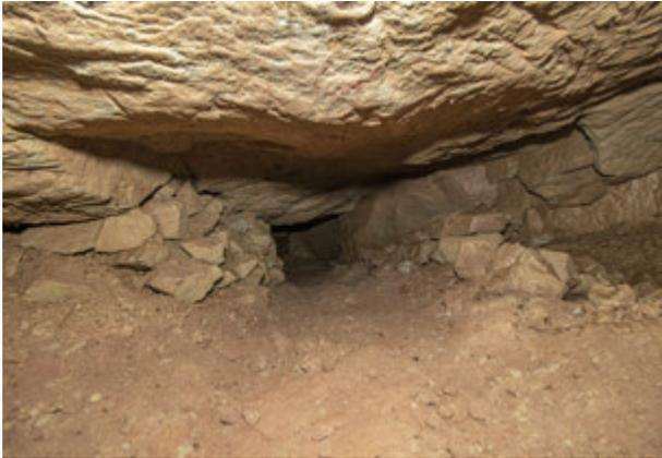
Abb. 147: Blick vom Stollen nach links in den ersten der beiden nach Süden abzweigenden Abbaubereiche, 2022. Der Bereich links im Bild wurde bis zur Firste mit Versatz gefüllt und mit einer Versatzmauer abgeschlossen (Foto: Deutsches Bergbau-Museum Bochum/G. Steffens).
