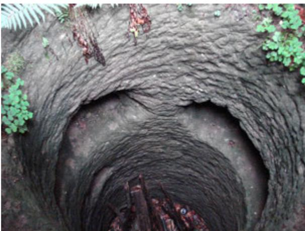
Abb. 50: Kordel-Butzweiler, Blick in einen der Schächte mit ausgearbeiteten Trittstufen, 2008 (Foto: Deutsches Bergbau-Museum Bochum/G. Körlin).
