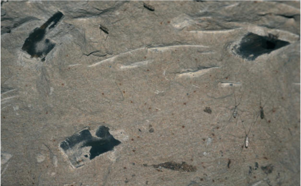
Abb. 9: Stollen Bruss, Abbaunische 2, 2010. Deutlich erkennbar sind die breiten, dunklen Spuren vom Abkeilen sowie die kurzen, dünnen Spuren einer Picke an der Firste (Foto: Deutsches Bergbau-Museum Bochum/G. Körlin).
