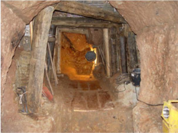
Abb. 272: Blick auf den massiven Verbruch mit dem großen Gesteinsbrocken im Stollen Bruss. Vorne im Bild ist der provisorische Holzausbau zu sehen, der später ersetzt wurde (Foto: Deutsches Bergbau-Museum Bochum/G. Körlin).
