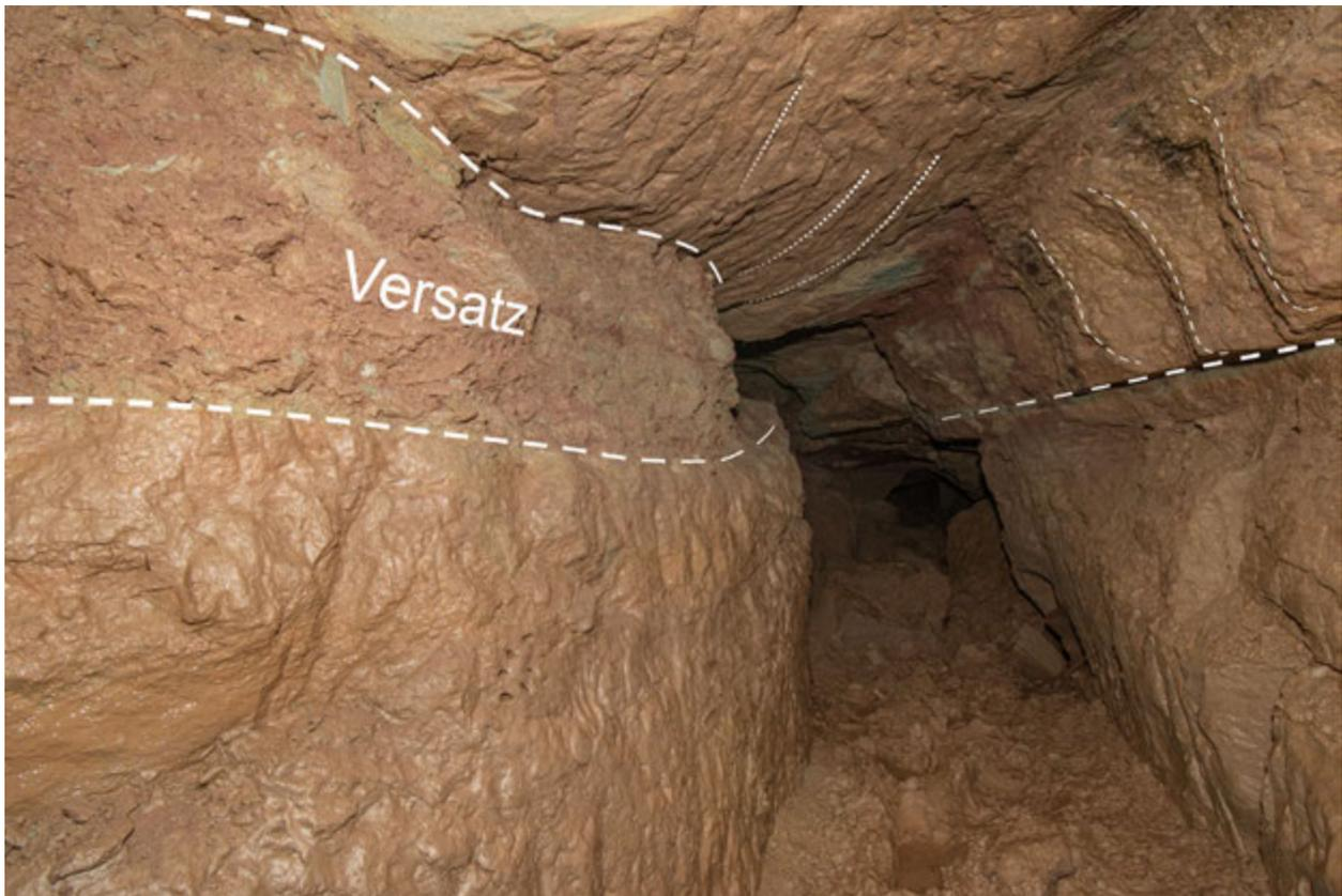
Abb. 146: Blick durch den Stollen Richtung bergwärts, 2022. Der rechte Stoß zeigt in dem oberen Bereich deutliche Absätze, Arbeitsfortschritte, sowie zwei Rußspuren dicht unter der Firste. Im oberen Bereich des linken Stoßes hat Abbau stattgefunden, der Bereich wurde nachträglich wieder versetzt. In diesem Bereich finden sich Spuren von Schlägel- und Eisenarbeit an der Firste (Foto: Deutsches Bergbau-Museum Bochum/G. Steffens).
