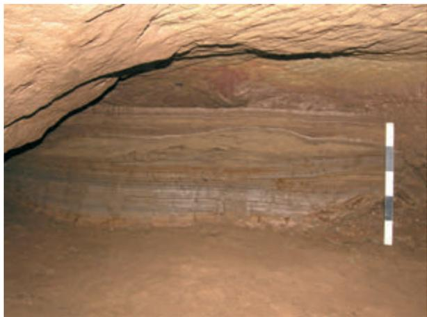
Abb. 181: Profil durch den Abbauraum dicht vor dem rechten Stoß im vorderen Bereich (ca. 4-2 m vom Stollen), 2009. Lediglich beim Maßstab befindet sich ein kleiner Teil Versatz in der Ecke, die restliche Verfüllung besteht aus Schwemmschichten aus sandigem und lehmigem Material (Foto: Deutsches Bergbau-Museum Bochum/G. Körlin).
