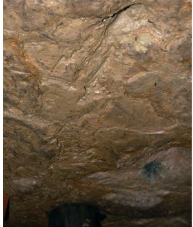
Abb. 216: Gezähespuren an der Firste des Abbauraums, die aus Richtung des Schachts 4 in den Abbauraum weisen, 2014. Am unteren Bildrand sind noch Reste der modernen Sicherung des Schachts zu erkennen (Foto: Deutsches Bergbau-Museum Bochum/G. Körlin).
