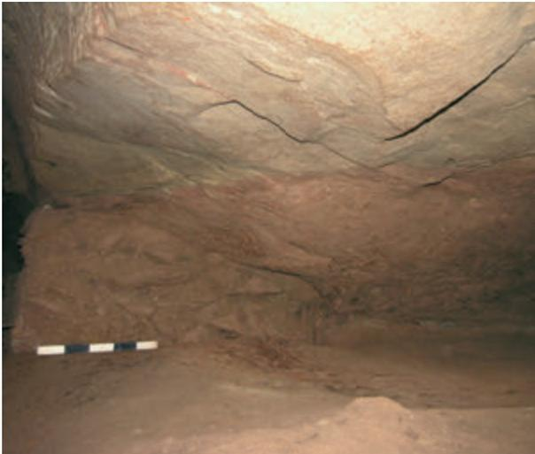
Abb. 289: Der Übergang vom Stollen zum Abbauraum, 2007. Hier wurde ein größerer Block von der Firste abgekeilt (Foto: Deutsches Bergbau-Museum Bochum/G. Körlin).
