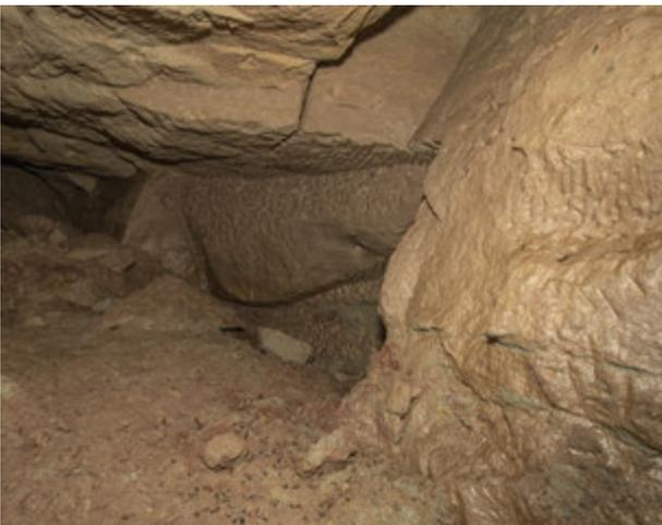
Abb. 149: Der unregelmäßig gearbeitete rechte (West-)Stoß des Abbaubereichs mit dem in den rechten Stoß eingearbeiteten Absatz am rechten Bildrand, 2022 (Foto: Deutsches Bergbau-Museum Bochum/G. Steffens).
