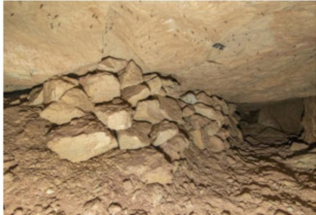
Abb. 148: Blick in den vom Stollen nach Süden abzweigenden Abbaubereich, 2022. Gut zu erkennen ist die bis zur Firste gestapelte Versatzmauer. An der Firste hat sich eine dunkle Keilspur erhalten (Foto: Deutsches Bergbau-Museum Bochum/G. Steffens).
