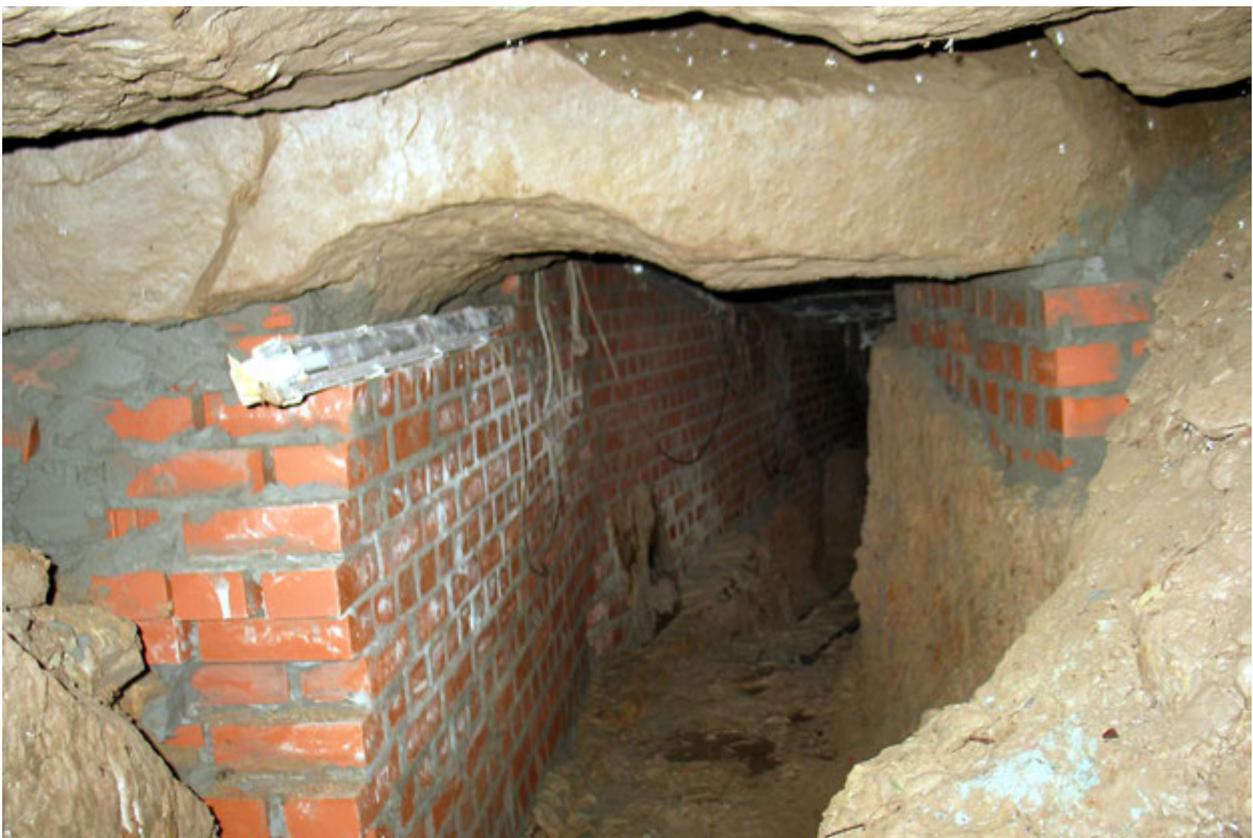
Abb. 274: Die unterfangene Firste, am oberen Bildrand ist die ursprüngliche Höhe der Firste zu erkennen (Foto: Deutsches Bergbau-Museum Bochum/S. Müller).
