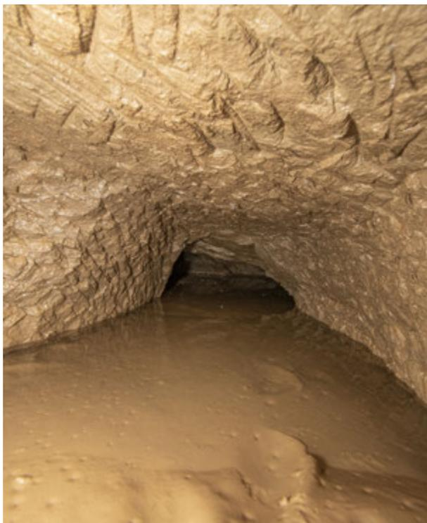
Abb. 155: Blick in das nahezu komplett zusedimentierte Teilstück des Stollens bei Lfm. 69, 2022. Am oberen Bildrand sind die feineren Spuren von Schlägel und Eisen zu erkennen, im anschließenden Teilstück kurze, kräftige Spuren (Foto: Deutsches Bergbau-Museum Bochum/G. Steffens).
