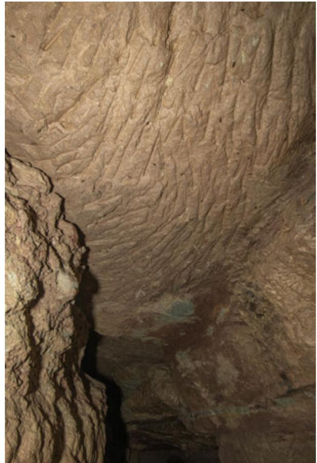
Abb. 285: Blick schräg hoch an die Firste im hinteren Bereich des Stollens Bruss, 2022. Gut zu erkennen die im Vergleich zu den Keilhauenspuren längeren Bahnen der Schlägel- und Eisenarbeit (Foto: Deutsches Bergbau-Museum Bochum/G. Steffens).
