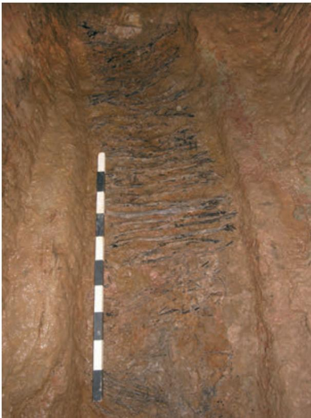
Abb. 108: Wasserseige zwischen Lfm. 24,6 (im Bild unten) und Lfm. 26,6 (oben) mit den verlegten Hölzern, Planum, 2009 (Foto: Deutsches Bergbau-Museum Bochum/G. Körlin).
