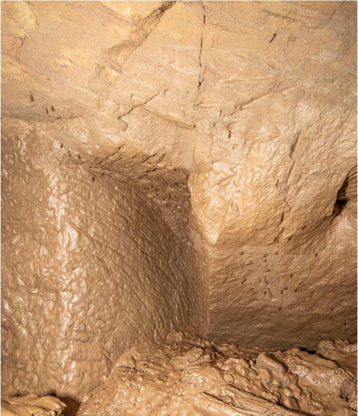
*Abb. 13: Abbaubereich im hinteren Teilstück des Stollens Bruss, 2022. Das Foto zeigt den rechten Stoß, hier wurde mit Schlägel und Eisen ein Schram angelegt (Bildmitte), um einen Sandsteinblock abzuweilen (links im Bild). Der Block zeigt die typischen langgezogenen Spuren der Schlägel- und Eisenarbeit (Foto: Deutsches Bergbau-Museum Bochum/G. Steffens).*
