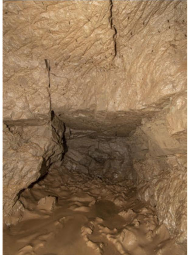
Abb. 143 und 144: Blick in die kurze Suchstrecke, die hinter der Verbruchzone nach Norden abzweigt, 2022. Der noch ein Stück weiter vorgetriebene Teil der Strecke kündigt von dem vergeblichen Versuch, eine abbauwürdige Vererzung zu finden (Fotos: Deutsches Bergbau-Museum Bochum/G. Steffens).
