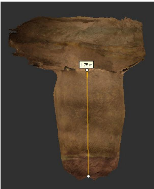
Abb. 219: Das Gesenk, Ausschnitt aus dem 3D-Modell, 2019. Farblich gut zu erkennen ist der Wechsel vom Sandstein oben zu der grauen, wasserführenden Schicht im unteren Bereich (Fotos: Deutsches Bergbau-Museum Bochum/M. Musberg, 3D-Umsetzung: Deutsches Bergbau-Museum Bochum/N. Schimerl).
