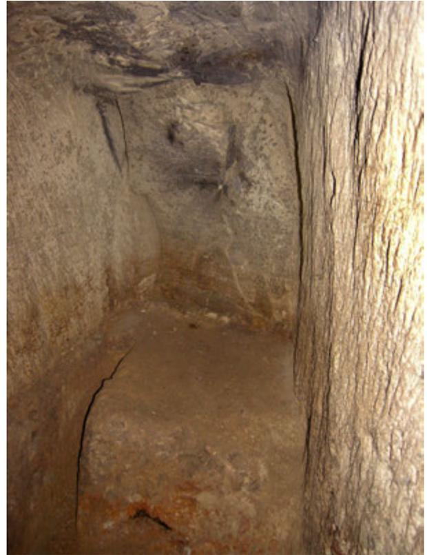
Abb. 286: Wallerfangen, Sonnenkuppe, 2007. Blick auf die neuzeitliche Ortsbrust, etwa Mitte 19. Jahrhundert. Am linken Stoß sieht man noch die Spuren des Schrams, wo die beiden oberen Blöcke bereits hereingewonnen wurden. Der unterste Block ist noch nicht gelöst, der Schram am linken Stoß wurde nicht vollendet (Foto: Deutsches Bergbau-Museum Bochum/G. Körlin).
