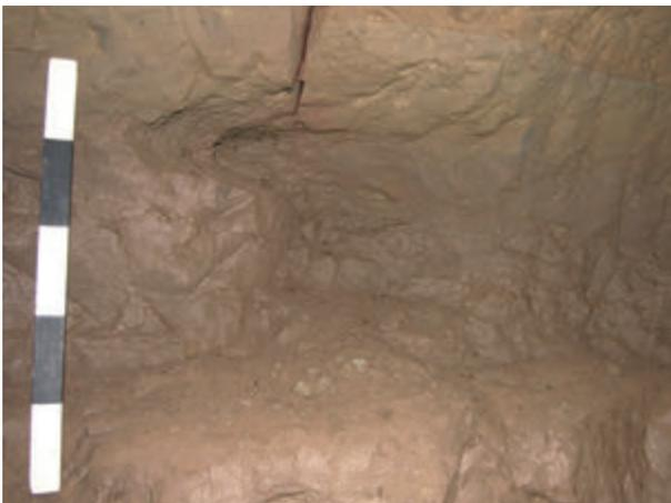
Abb. 121: Die in den linken Stoß eingetiefte Tasche 5, 2006. Über der Tasche ist eine Kluft gut zu erkennen, die möglicherweise zu einer kleinen Vererzung an dieser Stelle geführt hat (Foto: Deutsches Bergbau-Museum Bochum/G. Körlin).
