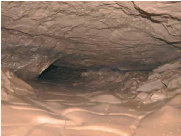
Abb. 180: Blick Richtung bergauswärts in den noch mit Versatz und Schwemmschichten verfüllten Bereich ganz im Nordosten des Abbauraums, 2011. Rechts im Bild der von Schwemmschichten überlagerte Versatz, links im Bild Wandpfeiler 11 (Foto: Deutsches Bergbau-Museum Bochum/G. Körlin).
