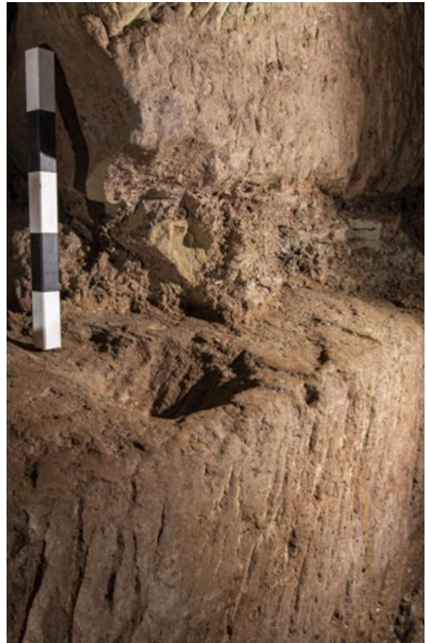
Abb. 225: In die Sohle vor dem linken Stoß, ungefähr auf einer Höhe mit Schacht 2, ist ein Stempelloch eingearbeitet, 2022. Im Hintergrund ist der große abgescherte Block zu sehen, der auf Versatz aufliegt (Foto: Deutsches Bergbau-Museum Bochum/G. Steffens).
