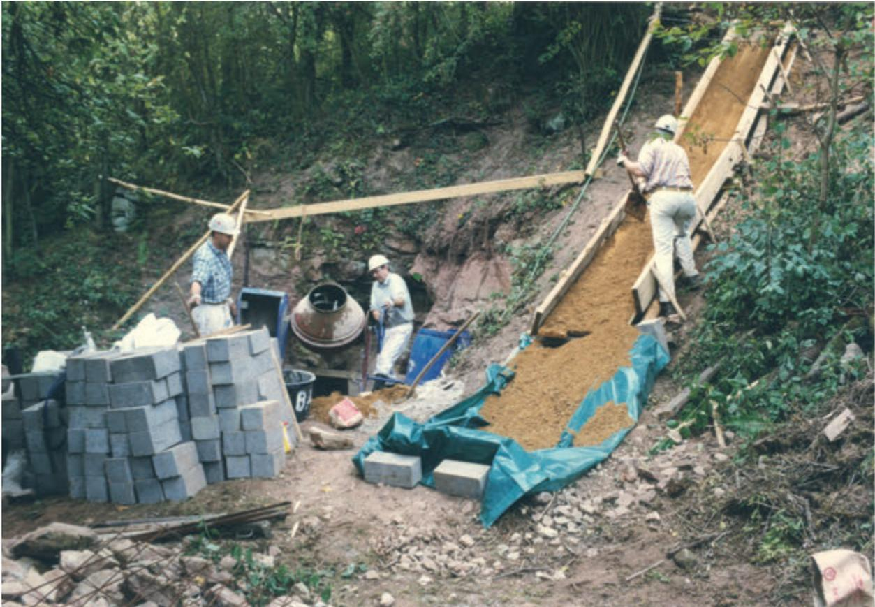
Abb. 268: Die für den Ausbau erforderlichen Materialien wurden mittels einer eigens vor Ort gebauten Rutsche das letzte Hangstück zum Mundloch transportiert (Foto: Deutsches Bergbau-Museum Bochum/S. Müller).
