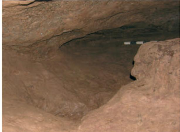
Abb. 198: Die Stützpfeiler 4 (links) und 5 (hinten) im Abbauraum, 2009. Im Vordergrund befindet sich das kleine Gesenk im Kriechgang. Am rechten Bildrand schließt sich der benachbarte, wesentlich niedrigere Abbaubereich mit einer Höhe von nur 35 cm an; der Absatz zeigt deutlich den Höhenunterschied (Foto: Deutsches Bergbau-Museum Bochum/G. Körlin).
