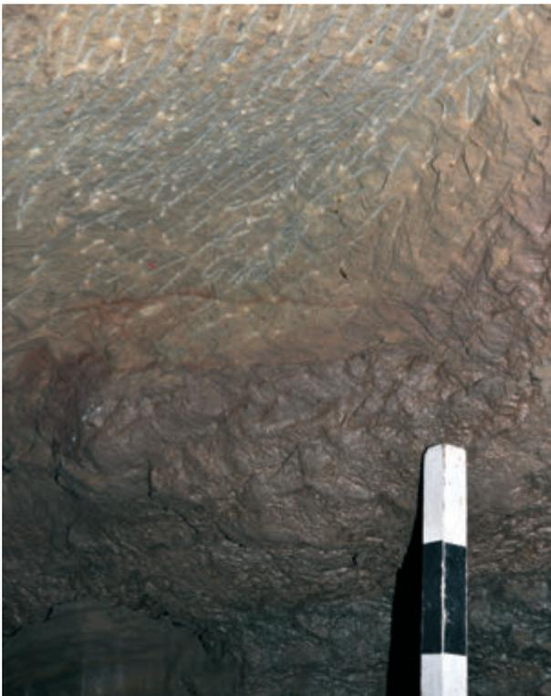
Abb. 185: Der Abbauraum, 2010. Sehr dicht beieinanderliegende Gezähespuren an der Firste nahe dem rechten Stoß (ca. Lfm. 3 vom Stollen aus) (Foto: Deutsches Bergbau-Museum Bochum/G. Körlin).
