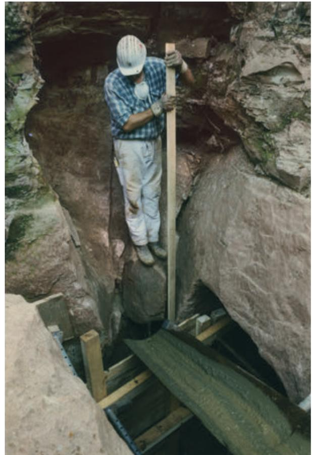
Abb. 267: Der Mundlochbereich wird durch massiven Steinausbau mit Betonverschalung gesichert (Foto: Deutsches Bergbau-Museum Bochum/S. Müller).
