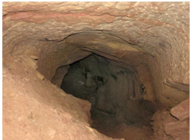
Abb. 98: Blick bergewärts in den Stollen Bruss auf Höhe des Abbauraums, 2006. Rechts im Bild der hier abzweigende Abbauraum, der noch mit Versatz gefüllt ist. Links die angeschütteten lockeren, sandig-lehmigen Erdschichten (Foto: Deutsches Bergbau-Museum Bochum/G. Körlin).
