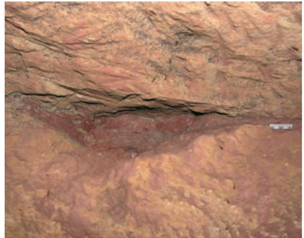
Abb. 119: Tasche 2, 2009. Im Bereich einer nahezu horizontal verlaufenden Kluft knapp unterhalb der Firste befindet sich eine langovale Ausbuchtung (Foto: Deutsches Bergbau-Museum Bochum/G. Körlin).
