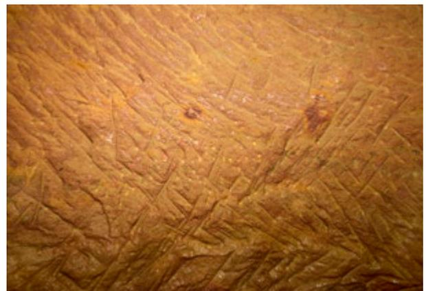
Abb. 222: Stoß des Gesenks mit weiteren Rostflecken in unterschiedlicher Größe, Tiefe ca. 1,1 m unter der Oberkante, 2019 (Foto: Deutsches Bergbau-Museum Bochum/M. Musberg).
