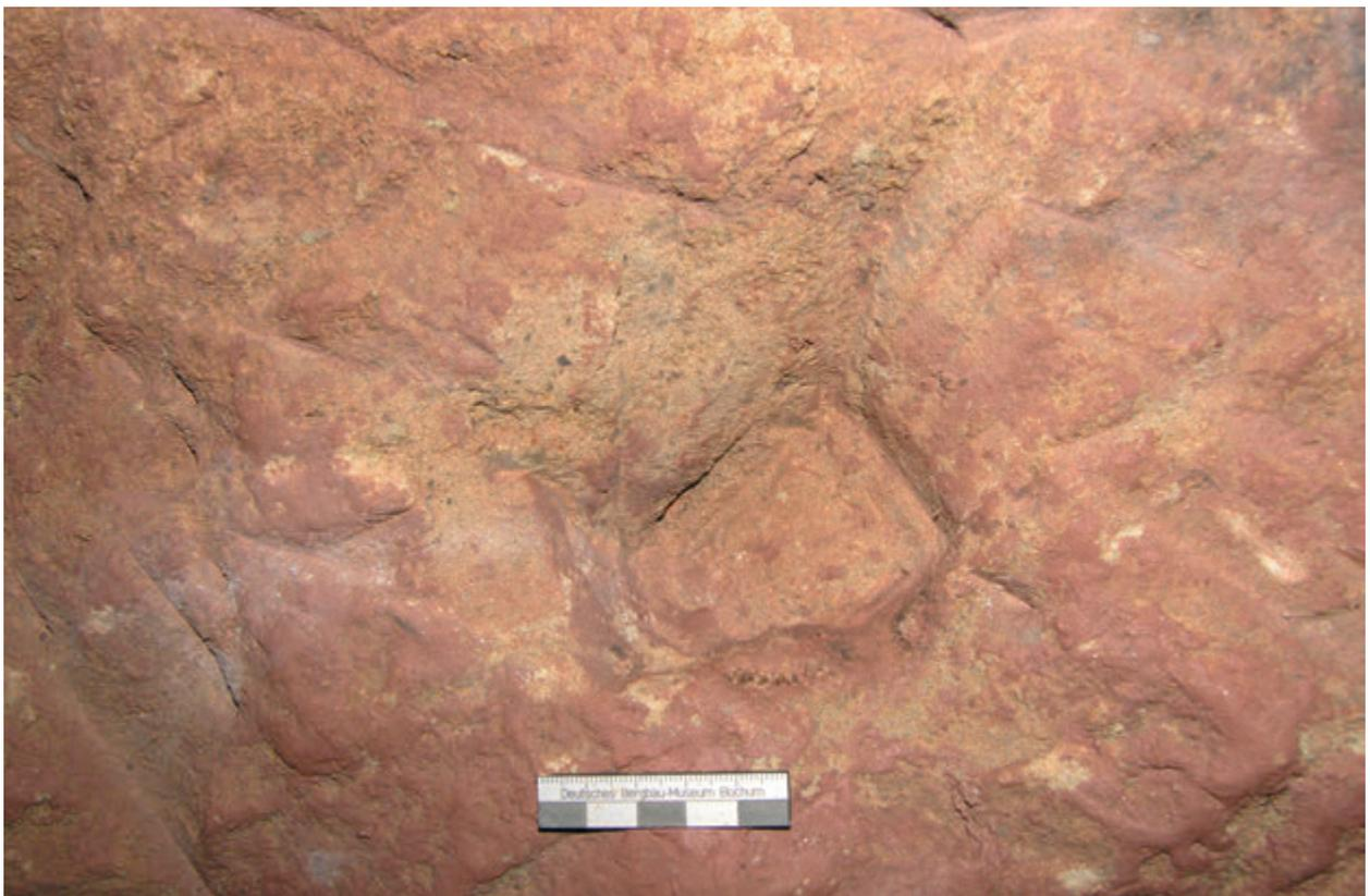
Abb. 231: Dicht unter der Firste, im abgerundeten Bereich auf der rechten Seite des Stollens, wurde eine relativ flache Vertiefung in den Stoß eingearbeitet, 2009 (Foto: Deutsches Bergbau-Museum Bochum/G. Körlin).
