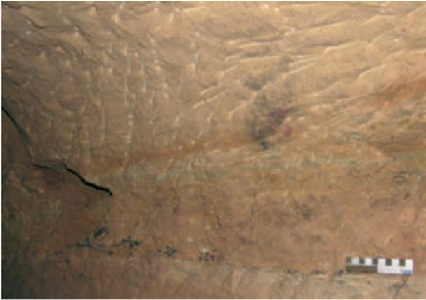
Abb. 127: Der linke Stoß etwa zwischen Lfm. 31,80 und Lfm. 32,40 mit den Keilhauenspuren, 2006 (Foto: Deutsches Bergbau-Museum Bochum/G. Körlin).
