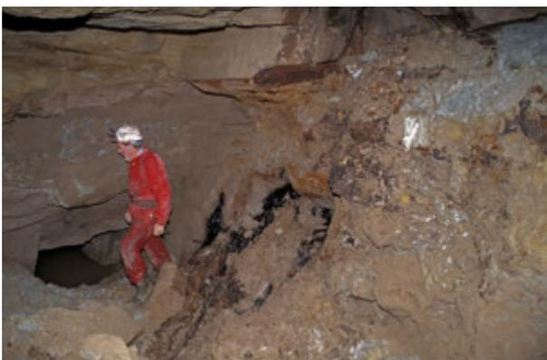
Abb. 140: Der Übergang von der Verbruchzone zum hinteren Bereich des Stollens, 1999. Durch den Verbruch staut sich hier das Bergwasser zurück (Foto: Deutsches Bergbau-Museum Bochum/G. Steffens).
