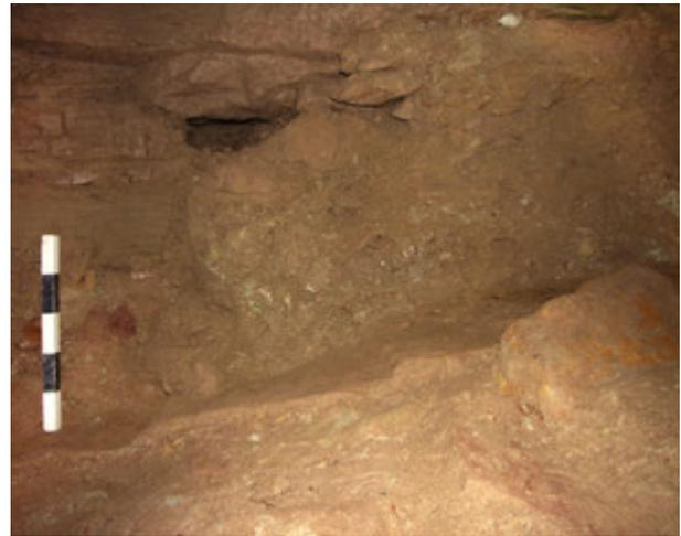
Abb. 100: Stufenförmige Absenkung der rechten Seite der Sohle zwischen Lfm. 44 und Lfm. 42,5, 2007. Im Hintergrund der noch mit Versatz und Schwemmschichten verfüllte Abbauraum bzw. Kriechgang (Foto: Deutsches Bergbau-Museum Bochum/G. Körlin).
