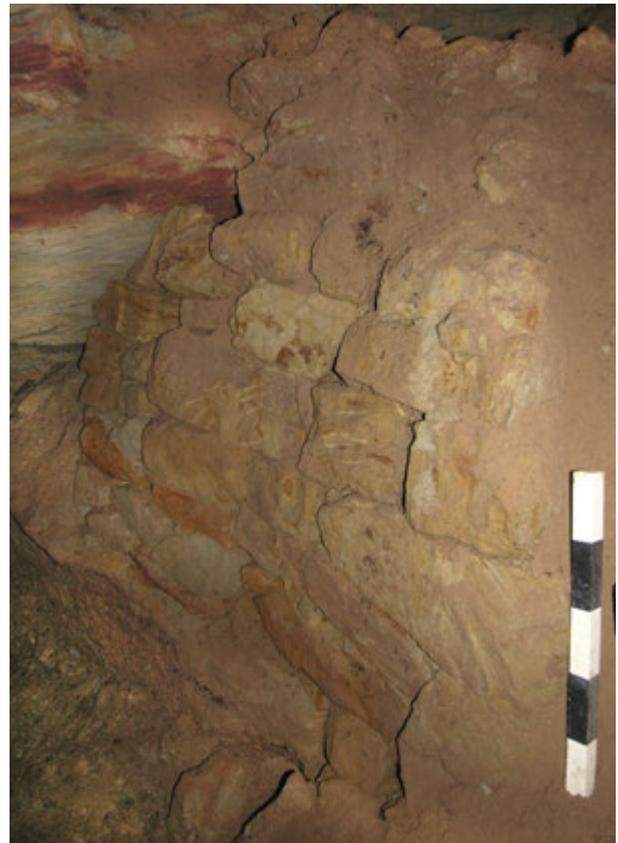
Abb. 138: Blick aus der Verbruchzone auf die Versatzmauer aus Sandsteinbrocken am Übergang vom Stollen zur Verbruchzone, 2006 (Foto: Deutsches Bergbau-Museum Bochum/G. Körlin).
