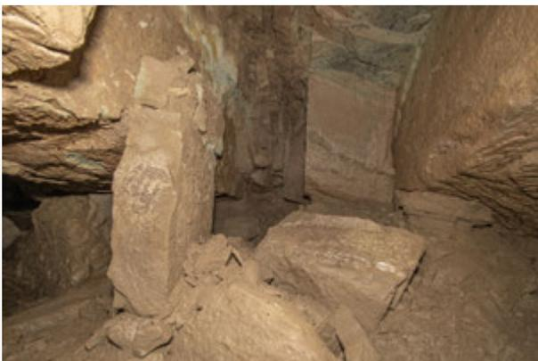
Abb. 145: Blick vom Stollen nach links (Süden) in die Störungszone, 2022. In der Mitte ist der verbrochene Bereich zu sehen, hier haben sich entlang der grauen Lettenschicht massive Sandsteinblöcke von der Firste gelöst, sie liegen noch auf der Sohle bzw. den darauf befindlichen Sedimentschichten auf. Ein weiterer abgescherter Block steht noch aufrecht an den Stoß gelehnt, links im Bild (Foto: Deutsches Bergbau-Museum Bochum/G. Steffens).
