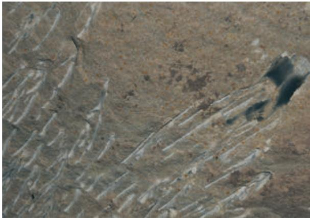
Abb. 131: Nahe dem rechten Stoß zeigen sich an der Firste im Abbauraum deutliche Spuren einer Pickaxe sowie eine breite, dunkle Spur vom Abkeilen, 2010 (Foto: Deutsches Bergbau-Museum Bochum/G. Körlin).
