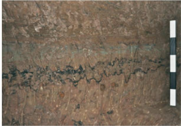
Abb. 128: Der linke Stoß bei Lfm. 34 mit den Keilhauenspuren nach der Reinigung vom anhaftenden Lehm, 2010. Die schwarzen Verfärbungen in der Bildmitte rühren von Manganausfällungen her (Foto: Deutsches Bergbau-Museum Bochum/G. Körlin).
