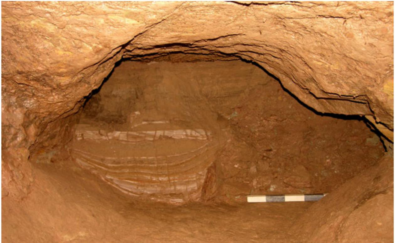
Abb. 162: Querprofil durch den Kriechgang, 2008. Die rechte Hälfte ist mit Versatz gefüllt, die linke zeigt viele Sedimentschichten (Foto: Deutsches Bergbau-Museum Bochum/G. Körlin).
