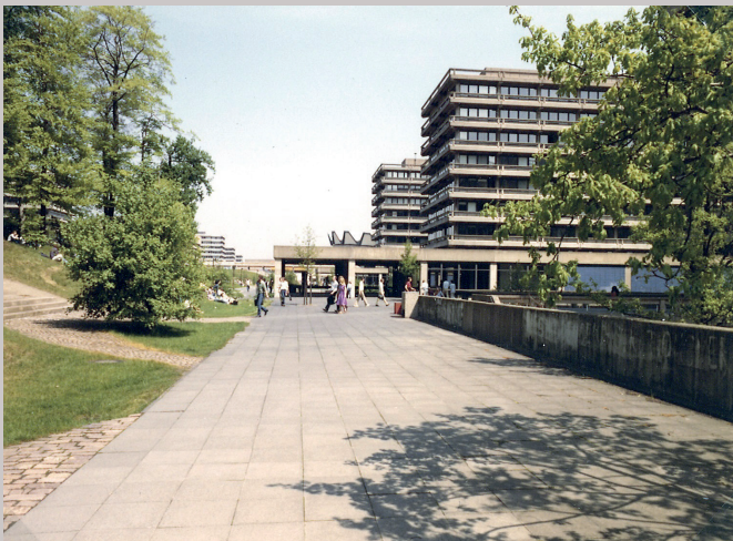
Abb. 17: Querforum West, Blick von Südwesten entlang der G-Gebäude, Stand 1981
