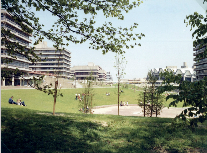
Abb. 15: Querforum West, Blick von Südwesten auf das modellierte Gelände, Stand 1981
