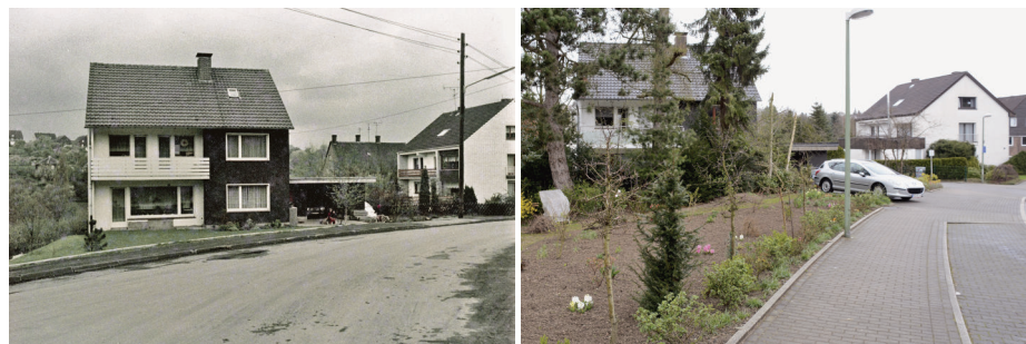
Abbildung 3.9: BO · DA · 04 Zweifamilienhäuser am Hang. Die 2 Häuser im Vordergrund wurden modernisiert, am linken Haus wurde der Vorgarten neu gestaltet, am rechten Haus eine Garage angebaut. Das Haus im Hintergrund (mi) wurde abgerissen und auf einem großen Hammergrundstück eine Reihenanlage mit 15 Häusern gebaut, die hinter den Bäumen liegt und nicht sichtbar ist. (Quelle: Scharioth und Schräpler 2017)
