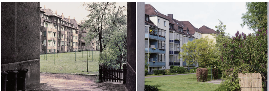
Abbildung 3.12: DU · NN · 04 Genossenschaftliche Wohnanlage. Die 3-geschossigen Wohnhäuser mit Wohngeschoss im Dach gehören zu einer größeren Wohnanlage der 1905 als Beamtenwohnungsverein gegründeten Wohnungsgenossenschaft Duisburg-Süd eG. Die Gebäude wurden inzwischen umfassend modernisiert, haben dabei Wärmedämmung, neue Fenster und Zentralheizung erhalten. Die rückwärtigen Loggien wurden durch vorgestellte Balkone vergrößert. Die zahlreichen Wäschestangen im Hof sind verschwunden, dieser wurde als zusammenhängende Grünanlage gestaltet. (Quelle: Scharioth und Schröppler 2017)
