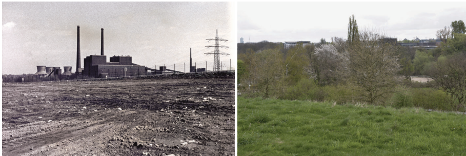
Abbildung 3.6: BO · WE · 06 Kraftwerk Springorum, Blick von der Deponie »Holtbrügge«. Das Kohlekraftwerk wurde 1958–61 errichtet und war eine weithin sichtbare Industrie-Kathedrale. 1986 wurde es stillgelegt. An seiner Stelle wurde der 9 ha große »Innovationspark Springorum« erschlossen, in dem sich Bürogebäude, eine Schule und das 1997 von Ratingen hierher gezogene »EBZ Europäisches Bildungszentrum der Wohnungs- und Immobilienwirtschaft« befinden. Das EBZ bietet mit 110 Lehrkräften und 200 freiberuflichen Dozenten Angebote für 1.400 Berufsschüler, 900 Studenten und zahlreiche Lehrgangsteilnehmer an. Der Park war 2016 noch nicht vollständig vermarktet. Derselbe Blick wie 1972 geht heute von der aufgeschütteten Deponie nach unten über eine Kleingartenanlage und einen Grüngürtel auf das frühere Kraftwerksgelände. (Quelle: Scharioth und Schräpler 2017)
