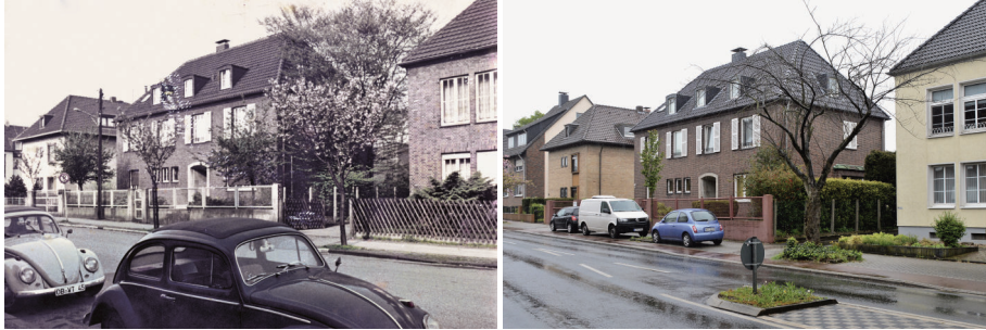
Abbildung 3.22: OB · ALO · 10 Hochwertige Mehrfamilienhäuser. Die Häuser im Stil der 20er-/30er-Jahre in der Kewerstraße wurden vermutlich für Führungskräfte der fußläufig gelegenen Zeche Alstaden gebaut. Das mittlere und das linke Haus sind äußerlich unverändert und gut instand gehalten, das Haus rechts versteckt seine Klinkerfassade hinter einem neuen Wärmedämmputz. Der Bürgersteig wurde erneuert und erhielt einen Radstreifen, ältere Straßenbäume wurden durch neue ersetzt. (Quelle: Scharioth und Schröppler 2017)
